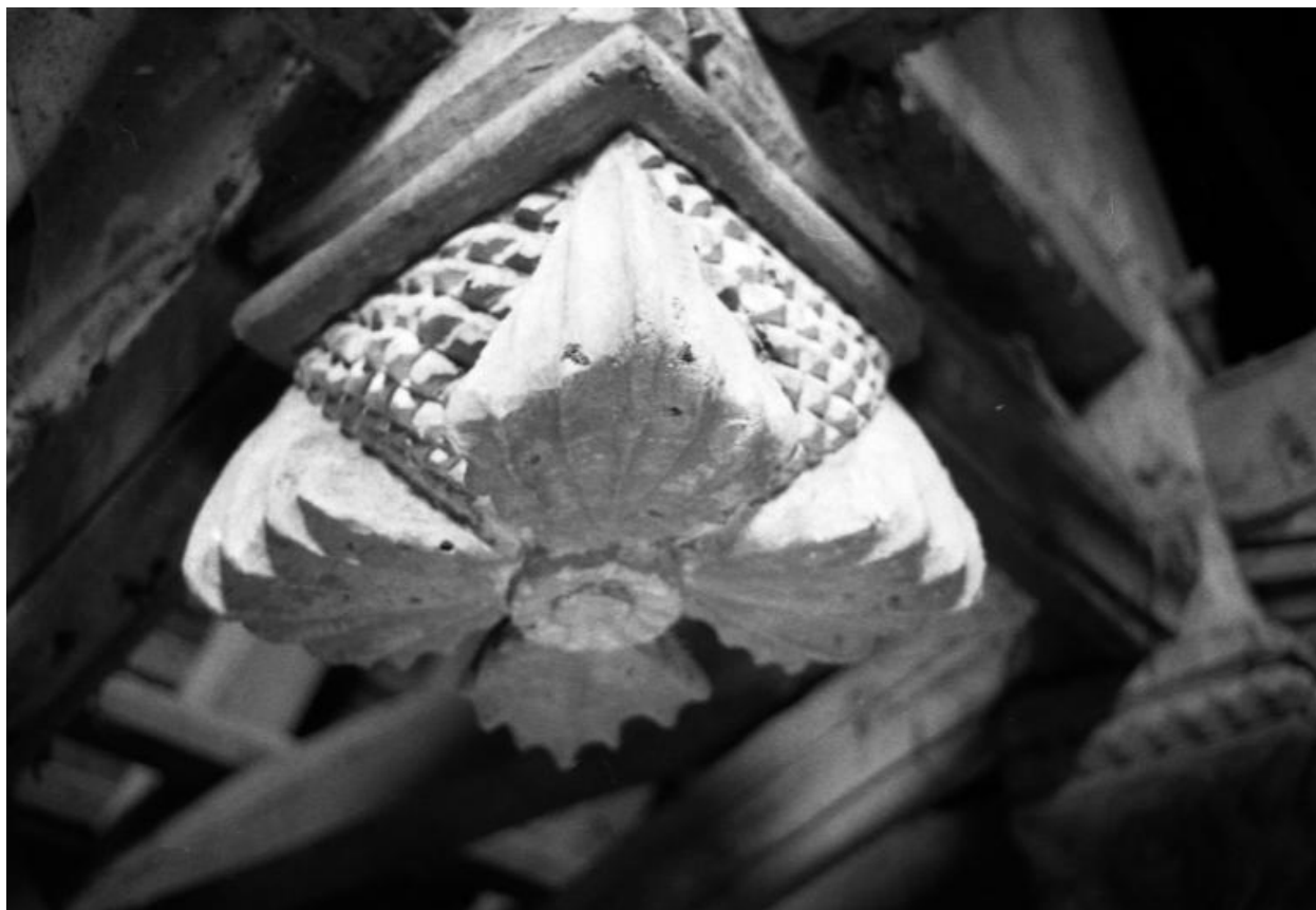
Charpente, détail de la clé 17.
