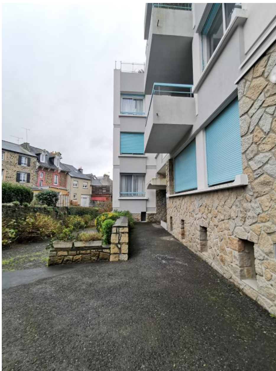
Vue de détail sur le soubassement et les murets en granit
