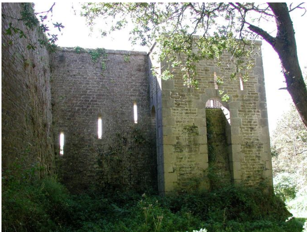
Vue du fort du Dellec : fossé sec flanqué par un bastionnet percé de créneaux de fusillade et doté d'un mâchicoulis ou créneau de pied
