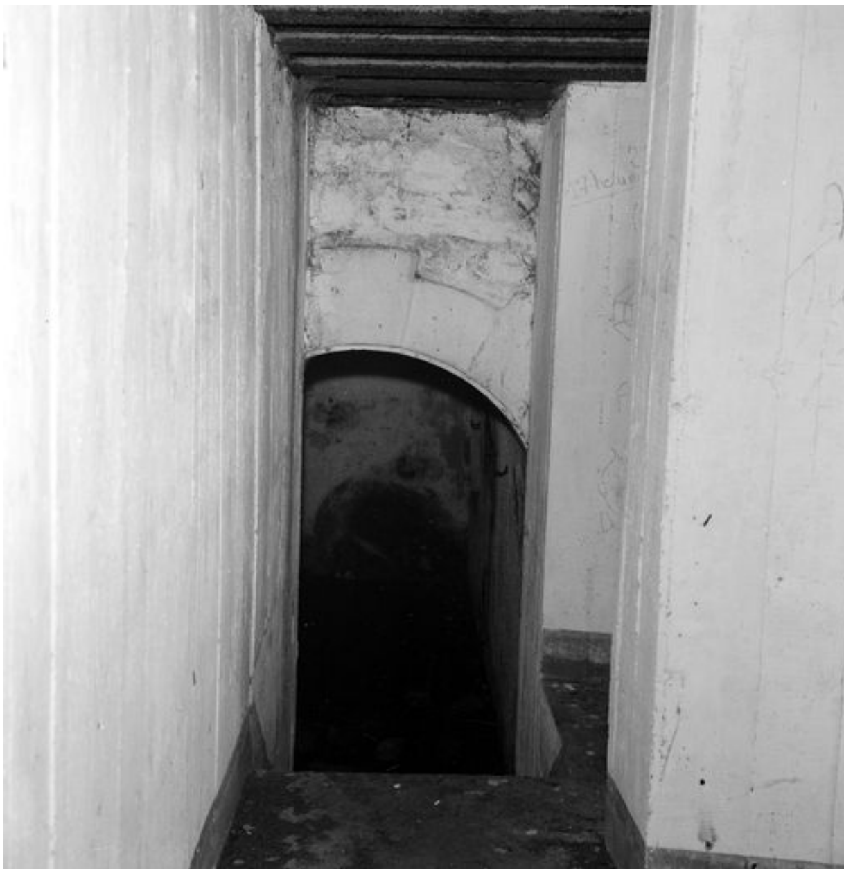
Vue de l'entrée du magasin à poudre sous roc de la batterie de côte en 1969. L'entrée originelle a été coiffée par un bunker - casemate de type 671
