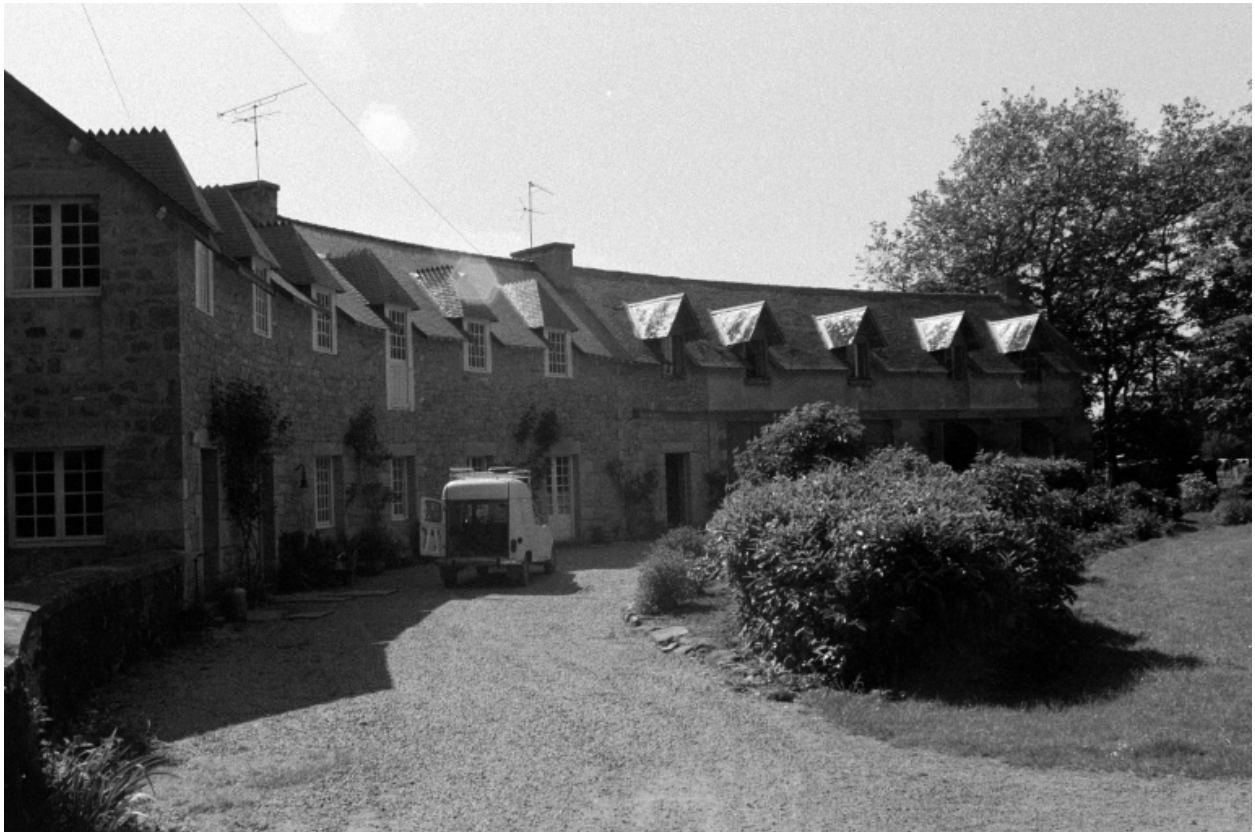
Communs ouest : anciennes écuries, remaniées. Etat en 1975.
