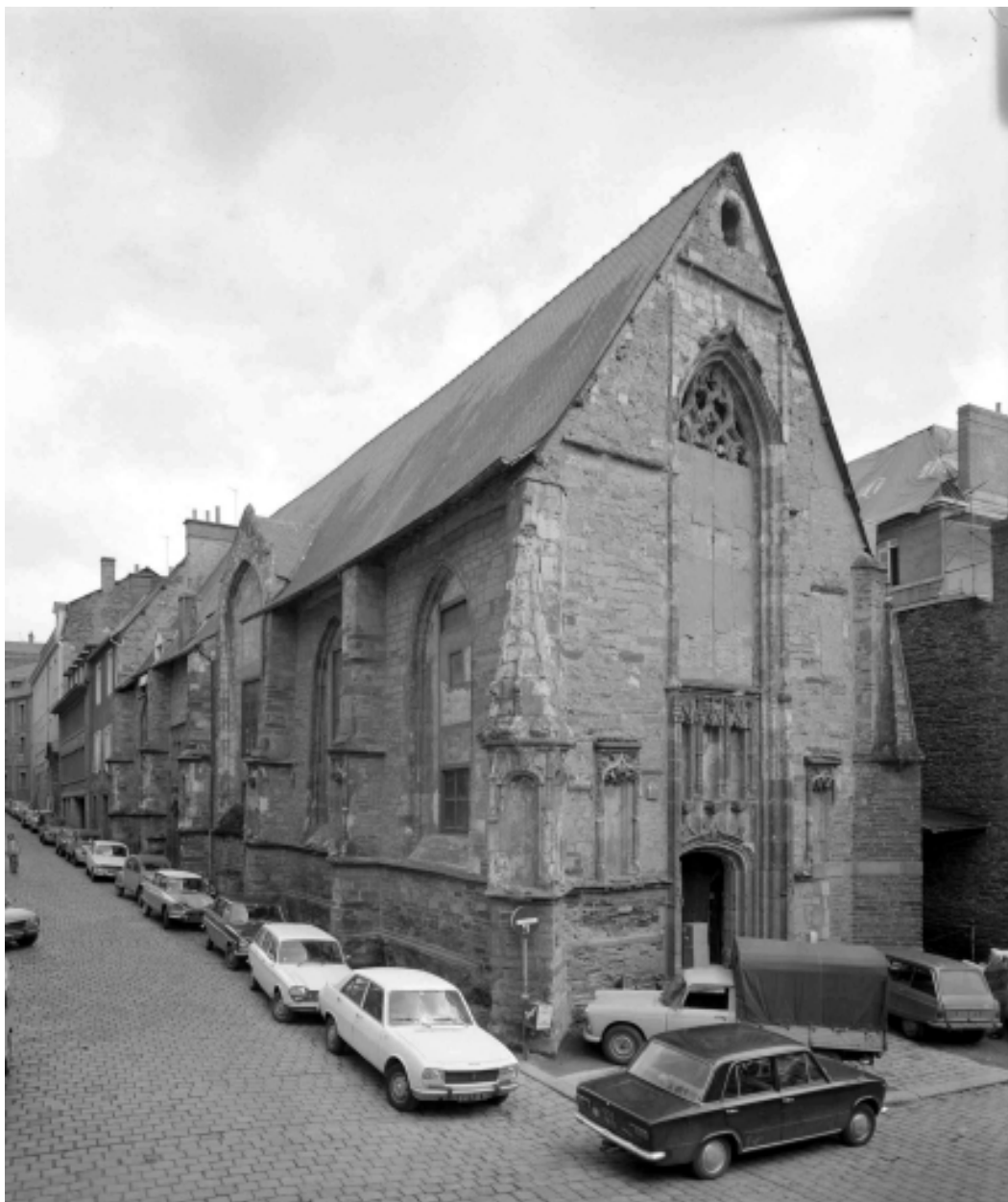
La chapelle, vue prise depuis le nord-ouest, en 1974
