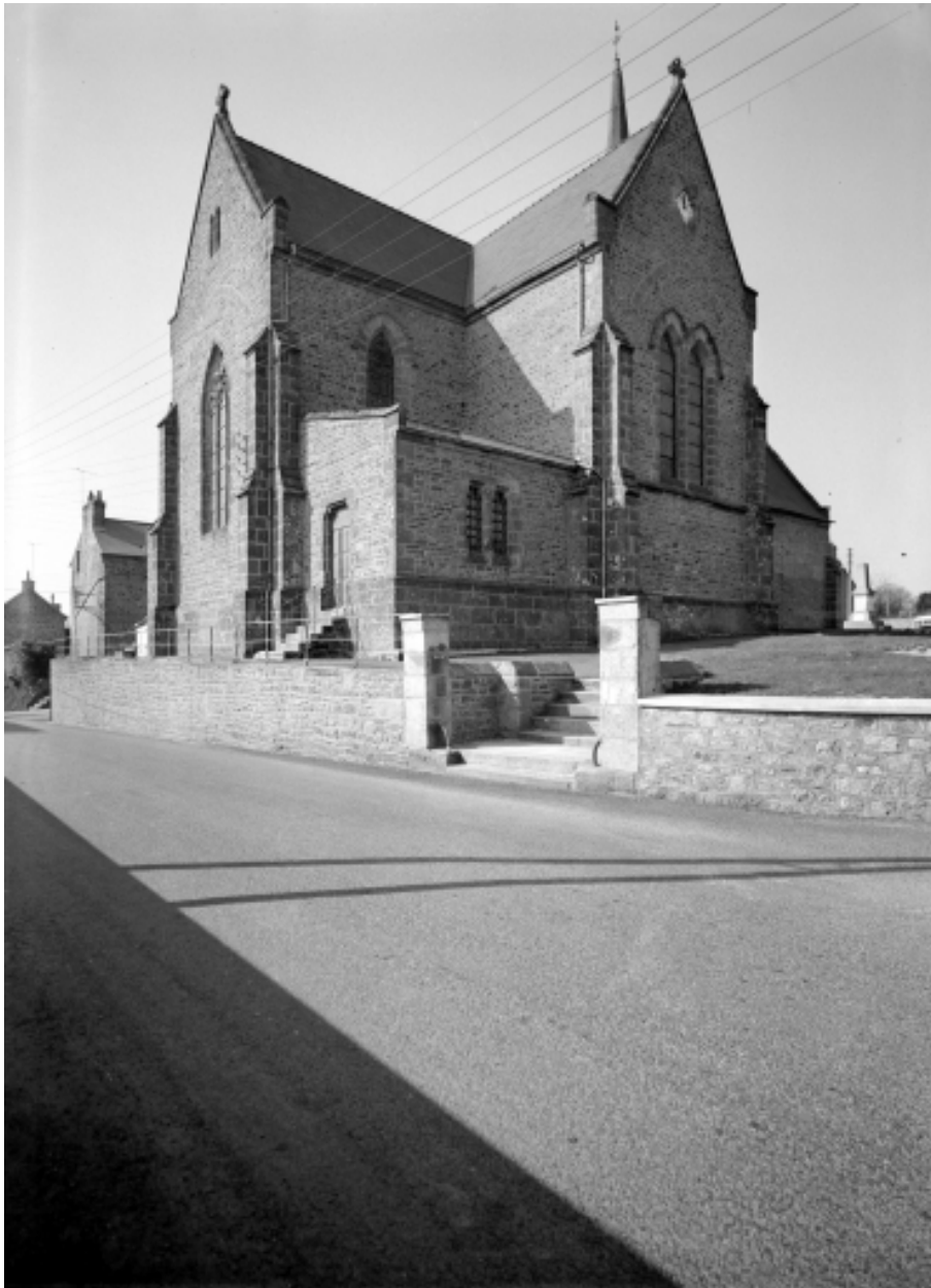
Elévation Nord-Est : vue générale.
