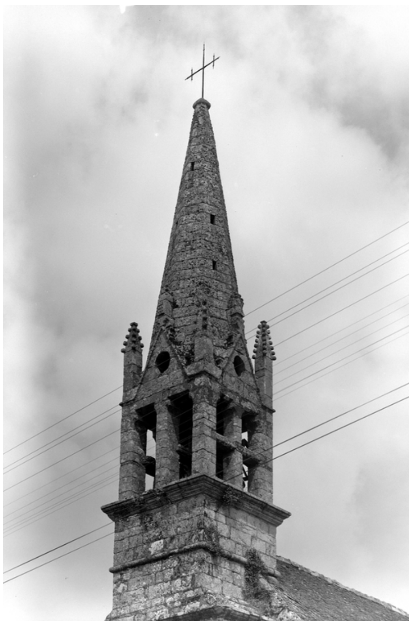
Détail du clocher : vue prise du sud ouest
