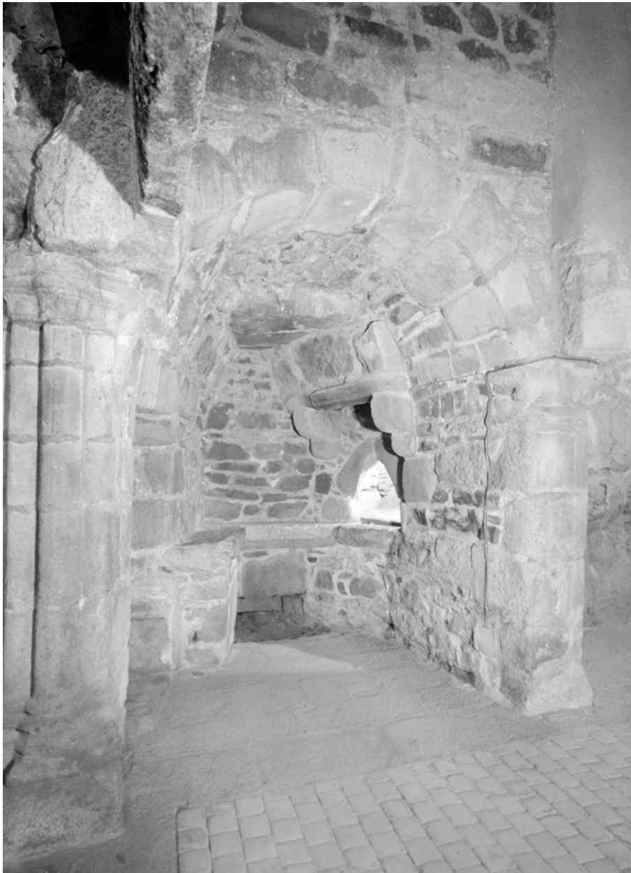
Vue de la cuisine : niche dans l'épaisseur du mur gouttereau postérieur, égout avec évacuation des eaux usées, niche avec placard mural, four avec sa hotte de cheminée (état en 1974)
