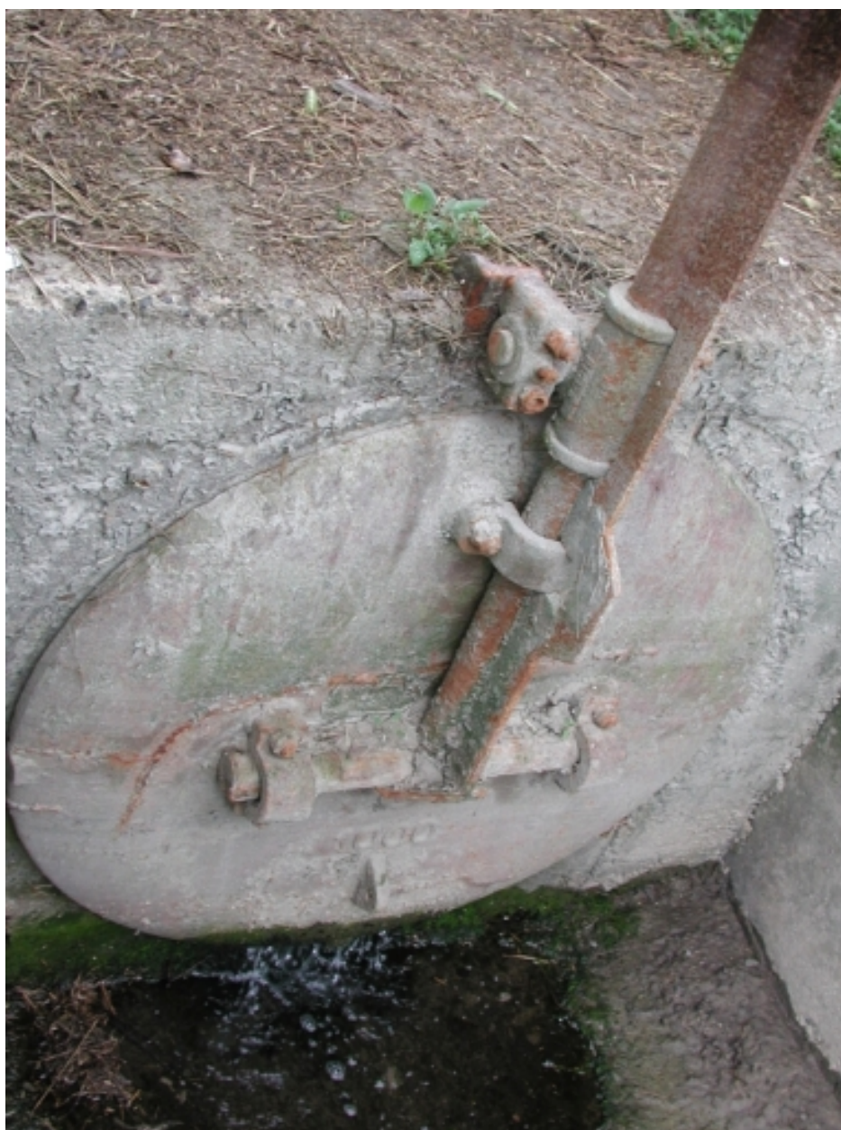
Clapet ou porte à la mer (écluse) du Saint-Jean
