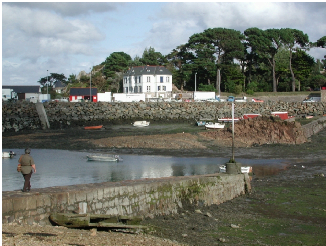
Vue générale de la cale Ouest
