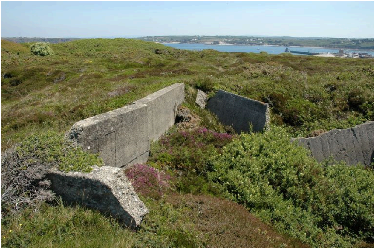
Vue des vestiges d'un bassin à eau en béton armé (état en 2005)
