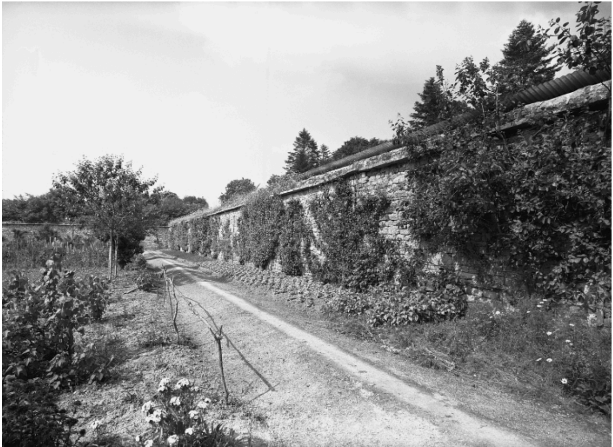
Jardin des communs : vue générale du mur d'enceinte
