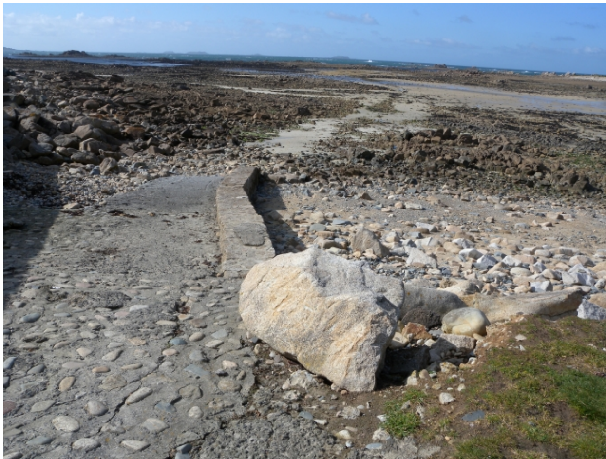
Vue de l'ancienne cale de Rohanig
