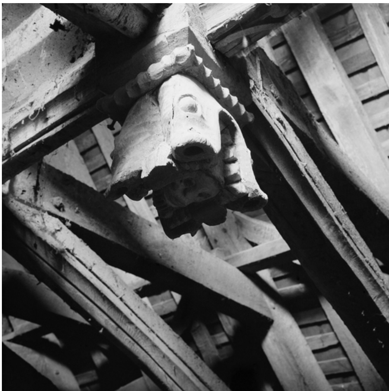
Charpente, détail de la clé 19.
