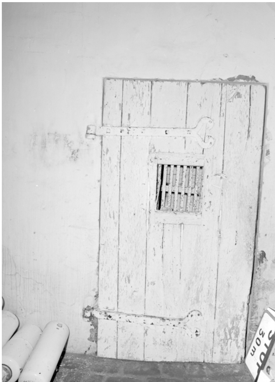
Cachot nord, vantail de porte, face intérieure.
