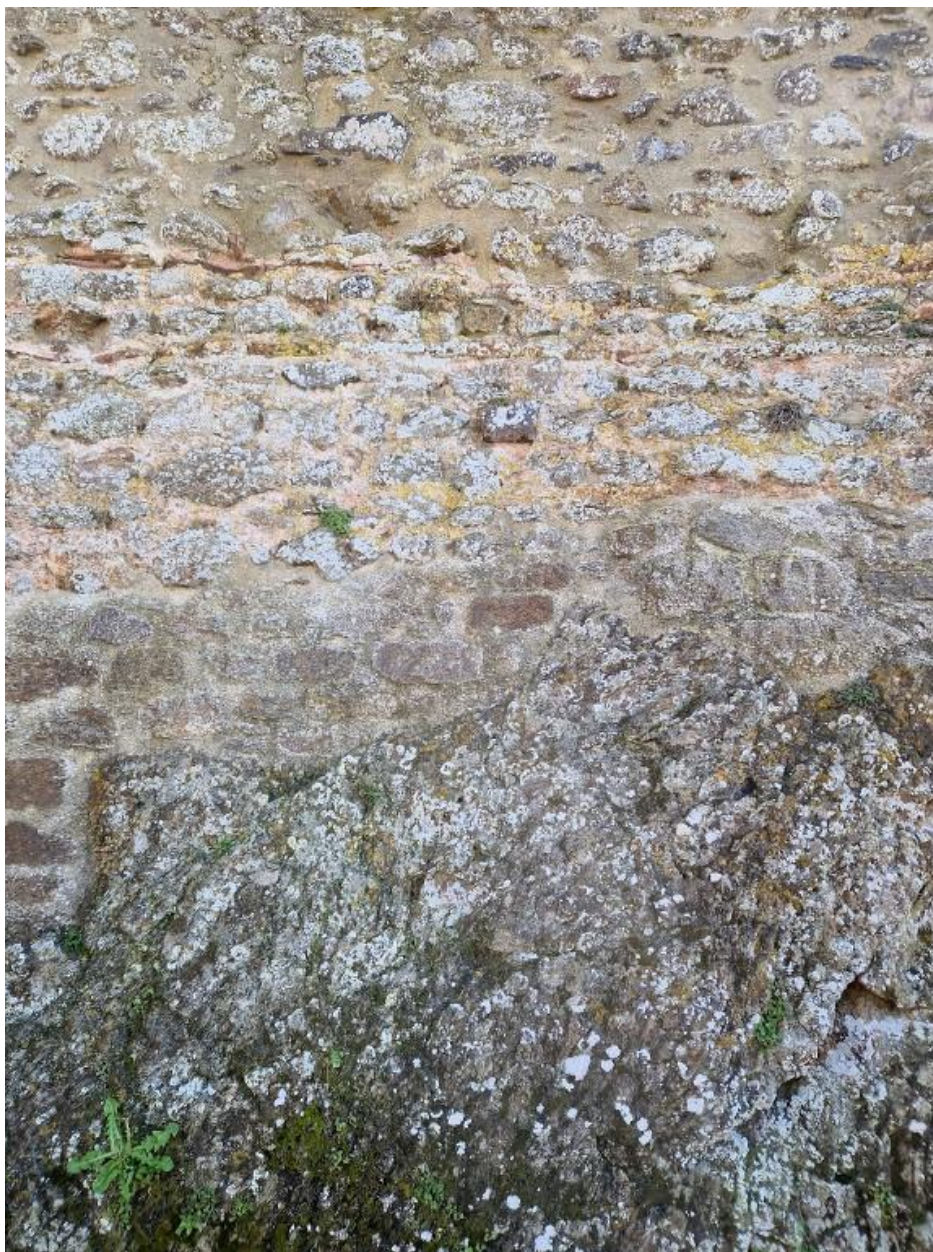
Vue de détail de l'élévation nord de la basse-cour : maçonnerie mêlant moellon et chaînage en brique correspondant au niveau d'occupation gallo-romain
