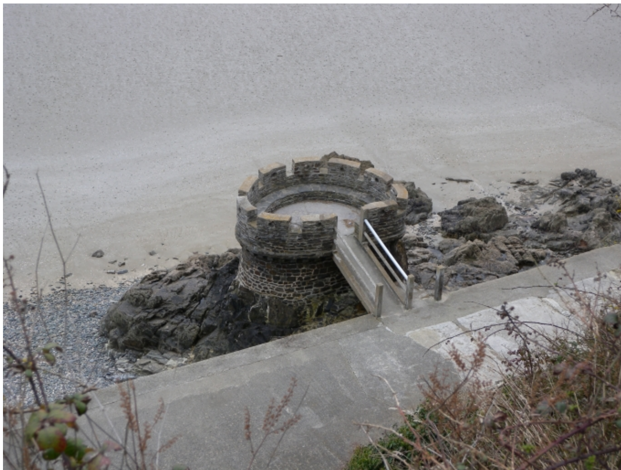
Vue en plongée de la tour située en face de la digue-promenade
