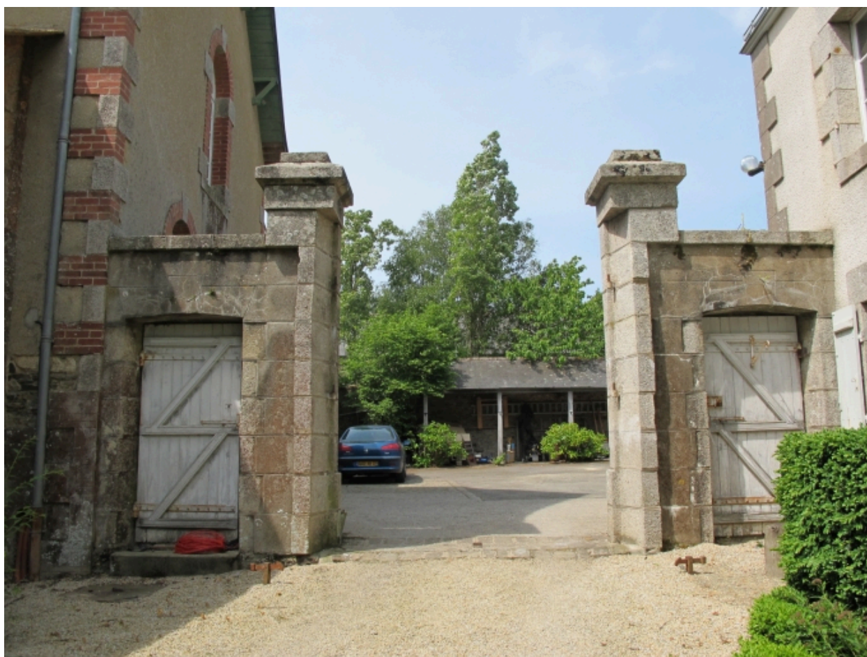
Portail de séparation avec la cour arrière
