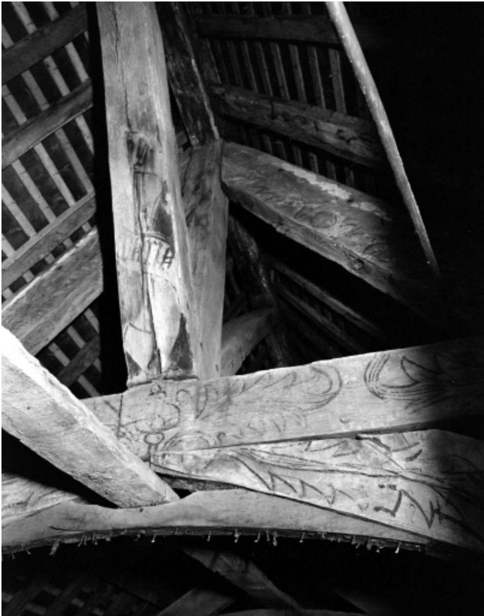
Détail sous charpente.
