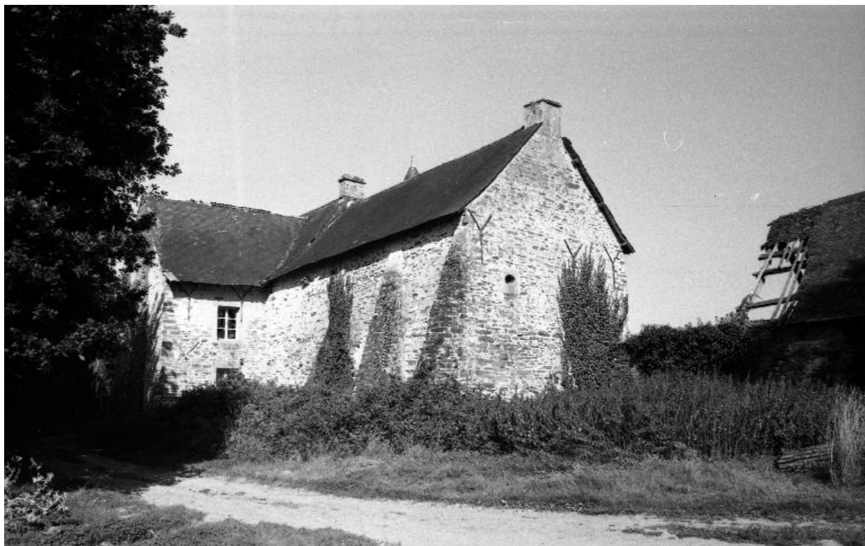
Corps de logis : vue d'ensemble de la façade nord-ouest de la partie ouest
