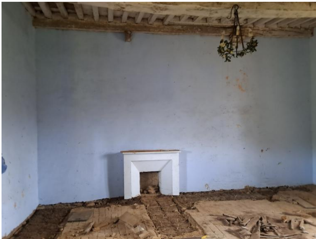
Premier étage, partie est, seconde salle à gauche de l'escalier
