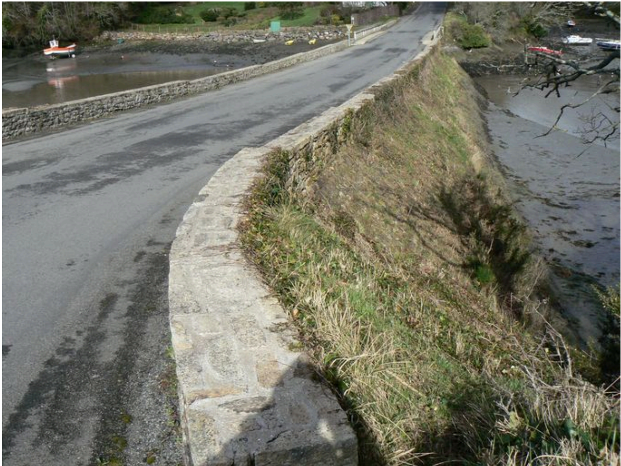
Perré incliné de la digue-route de Pont Du
