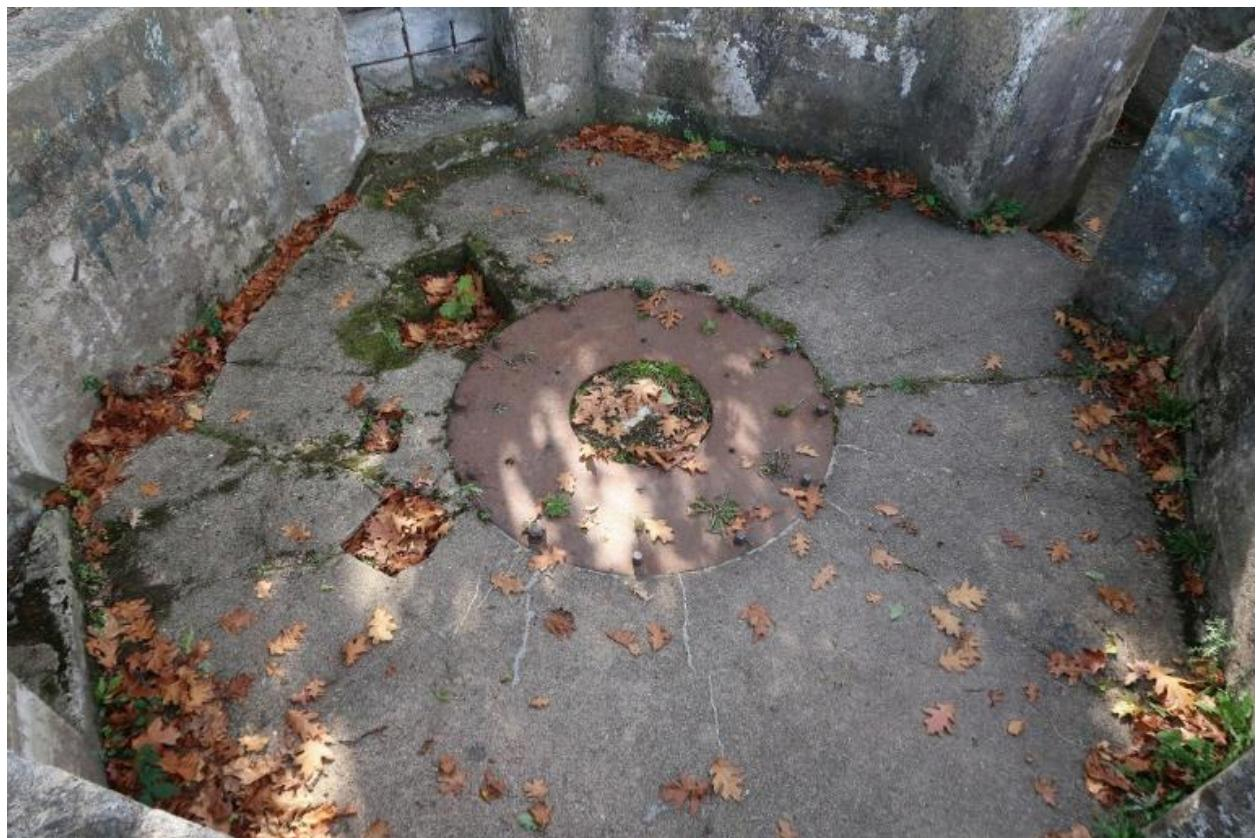
Vue de la cuve du télémètre. Au centre, la platine de fixation avec ses douze tiges filetées
