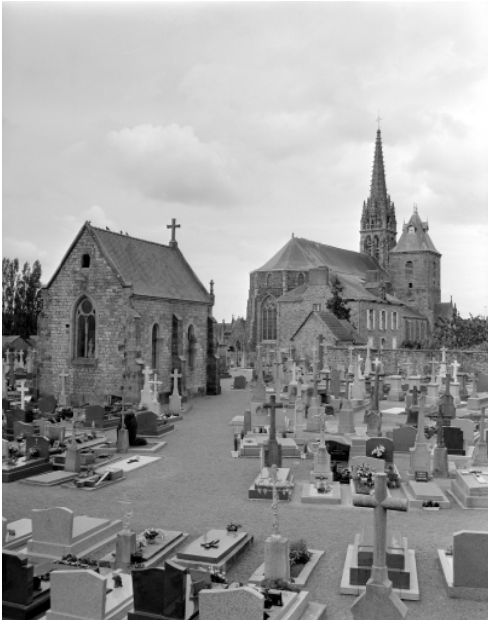
Elévation Ouest : vue de situation
