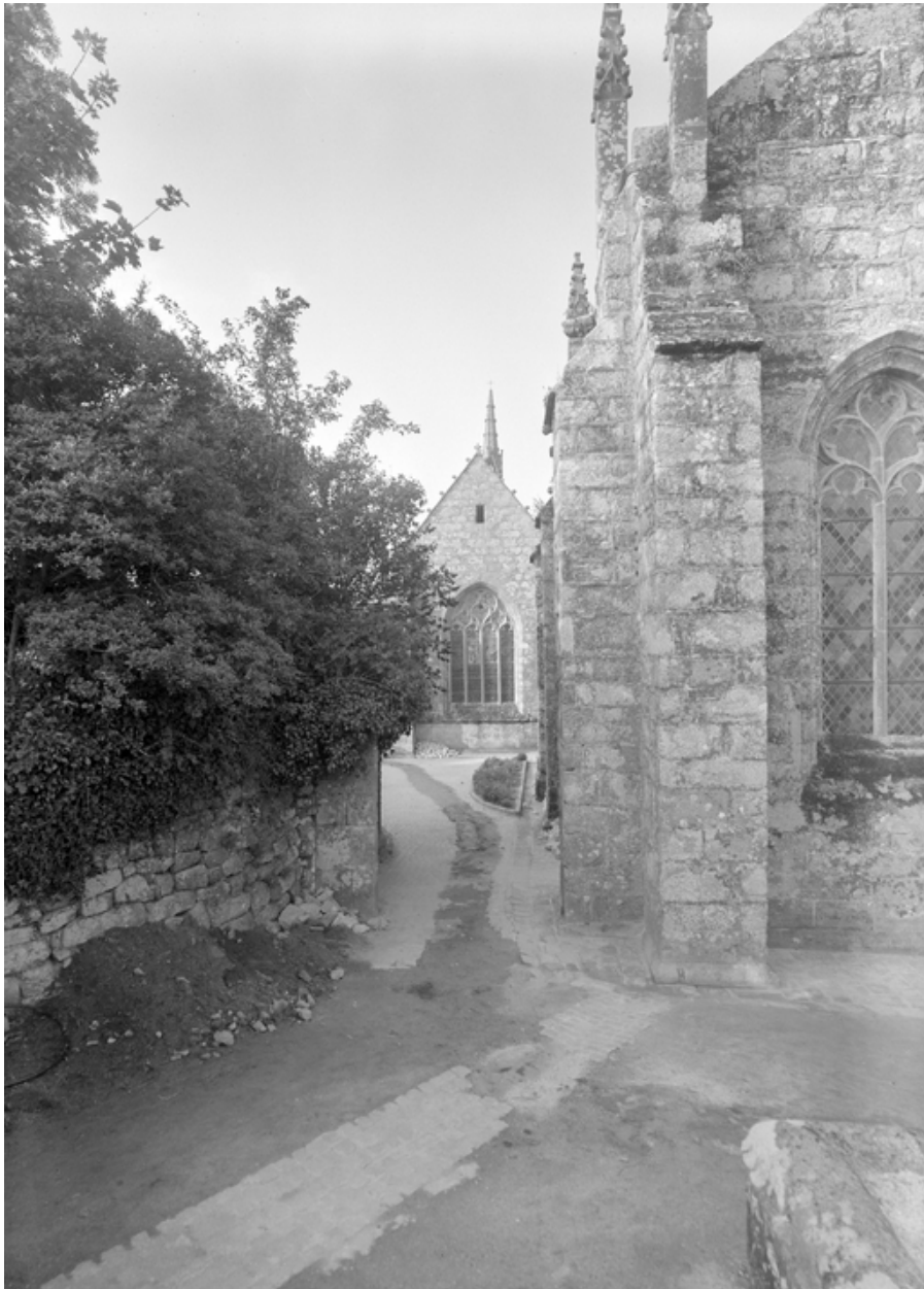
Façade est, vue générale
