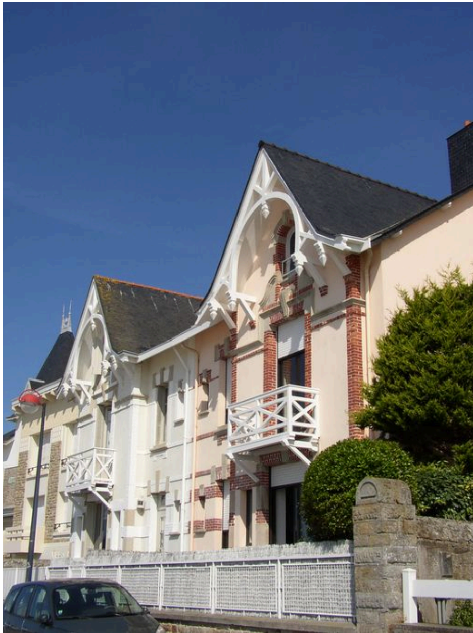
Maison de villégiature du 24 boulevard de Toulhars
