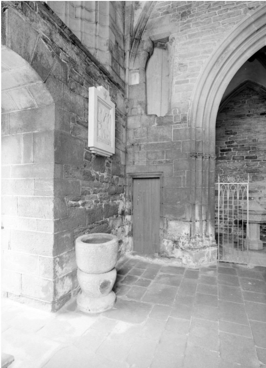
Nef, angle nord-ouest, porte d'accès à la tour d'escalier ; au-dessus, porte d'accès pour une tribune.
