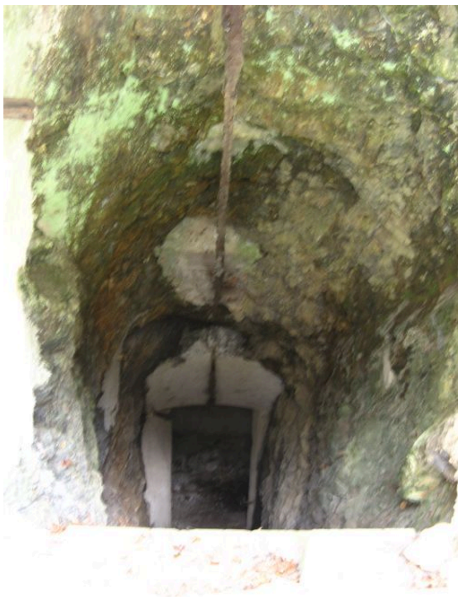
Intérieur d'un abri de la batterie haute de Robert
