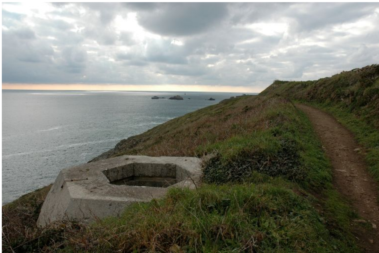
Vue de situation le long du chemin côtier (état en 2006)
