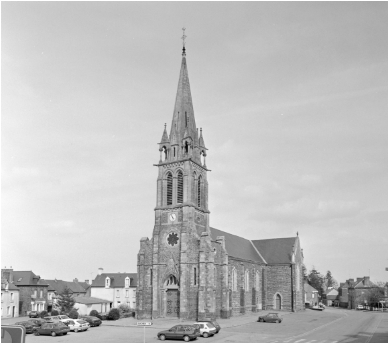
Elévation Ouest : vue générale
