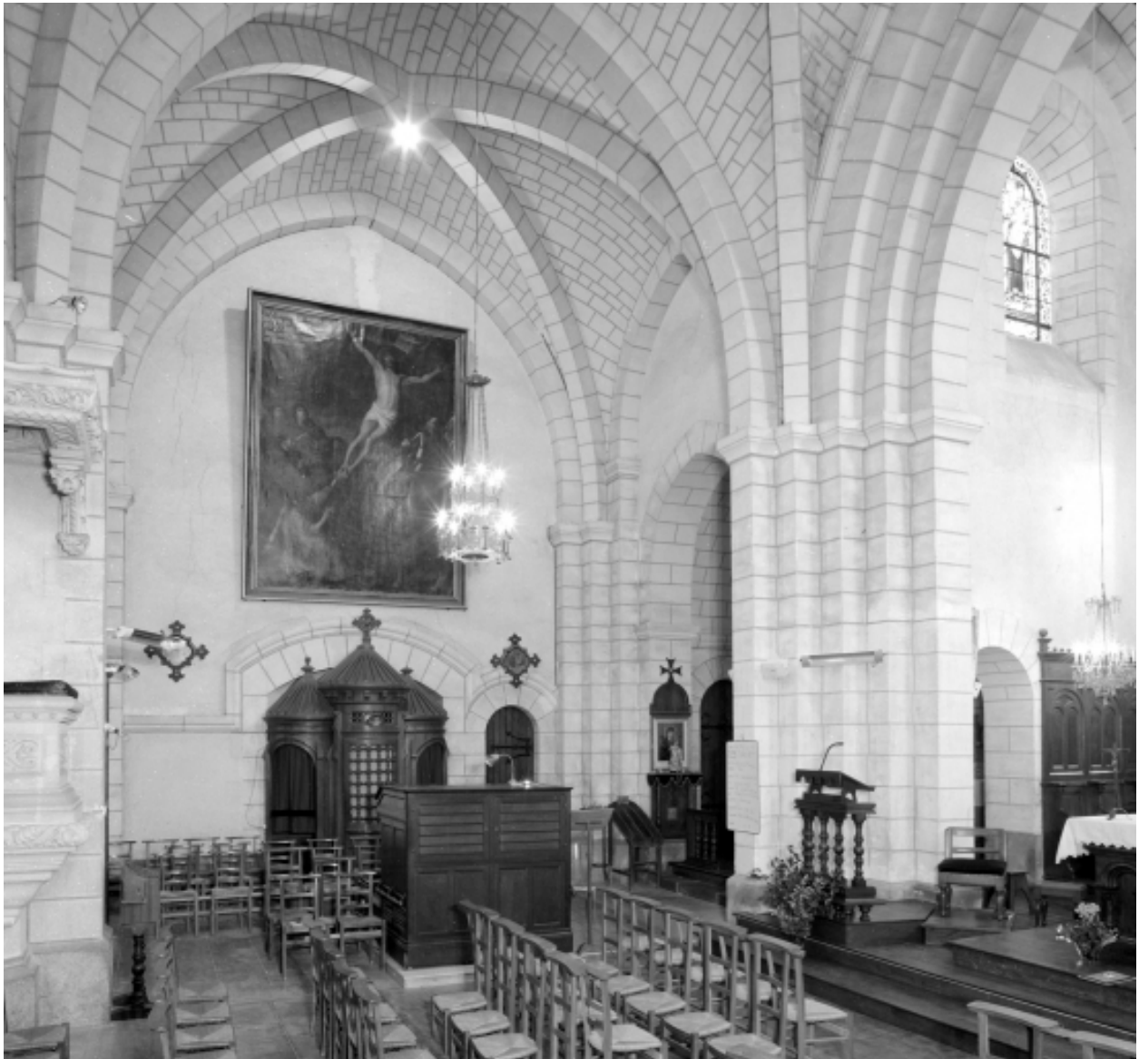
Elévation Sud-Ouest : vue générale
