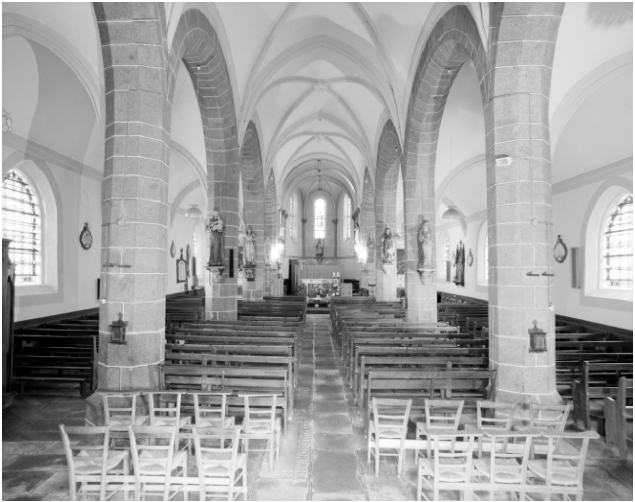
Intérieur : vue générale vers le chœur.
