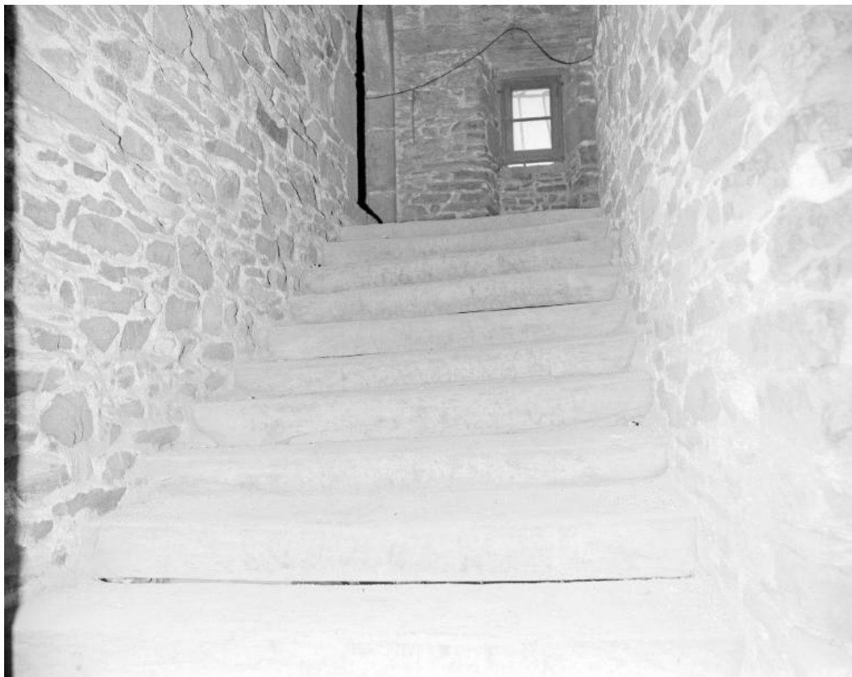
Intérieur, volée d'escalier.
