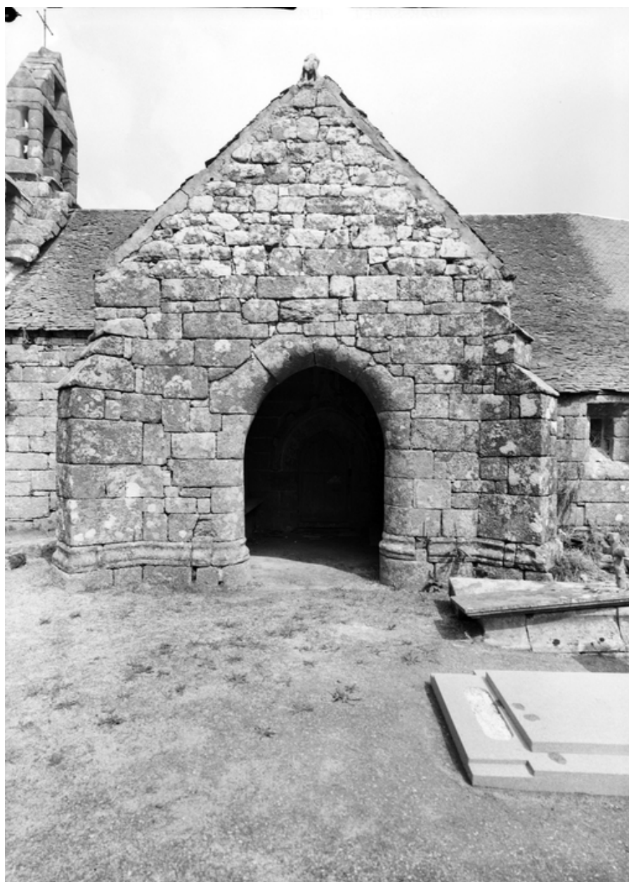
Pignon du porche sud
