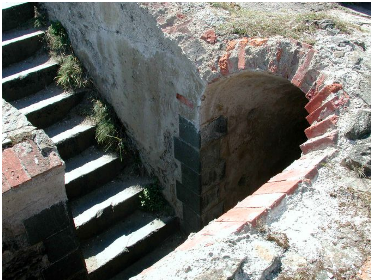
Vue du réduit de batterie de côte de l'île de l'Aber : terrasse, escalier
