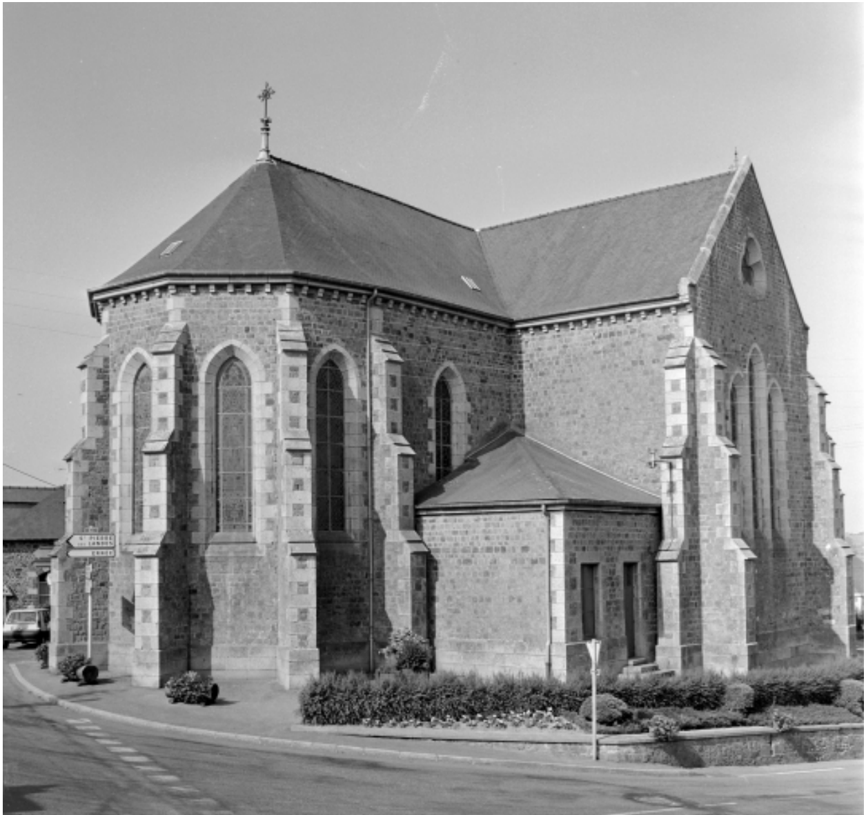
Élévation Nord-Est : vue générale
