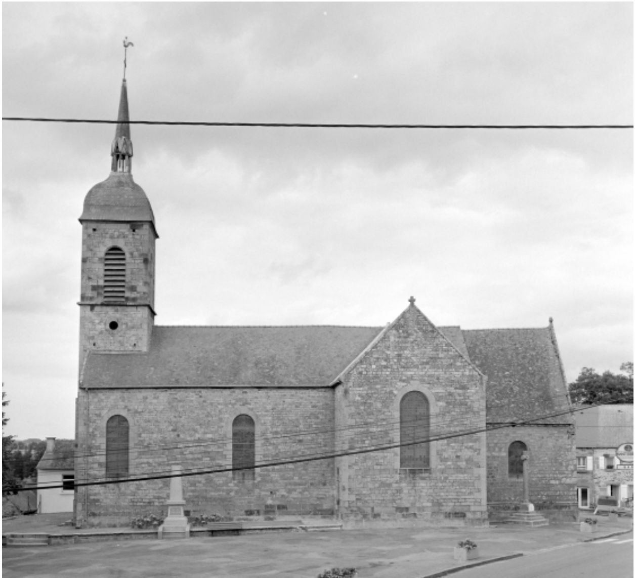
Elévation sud : vue générale
