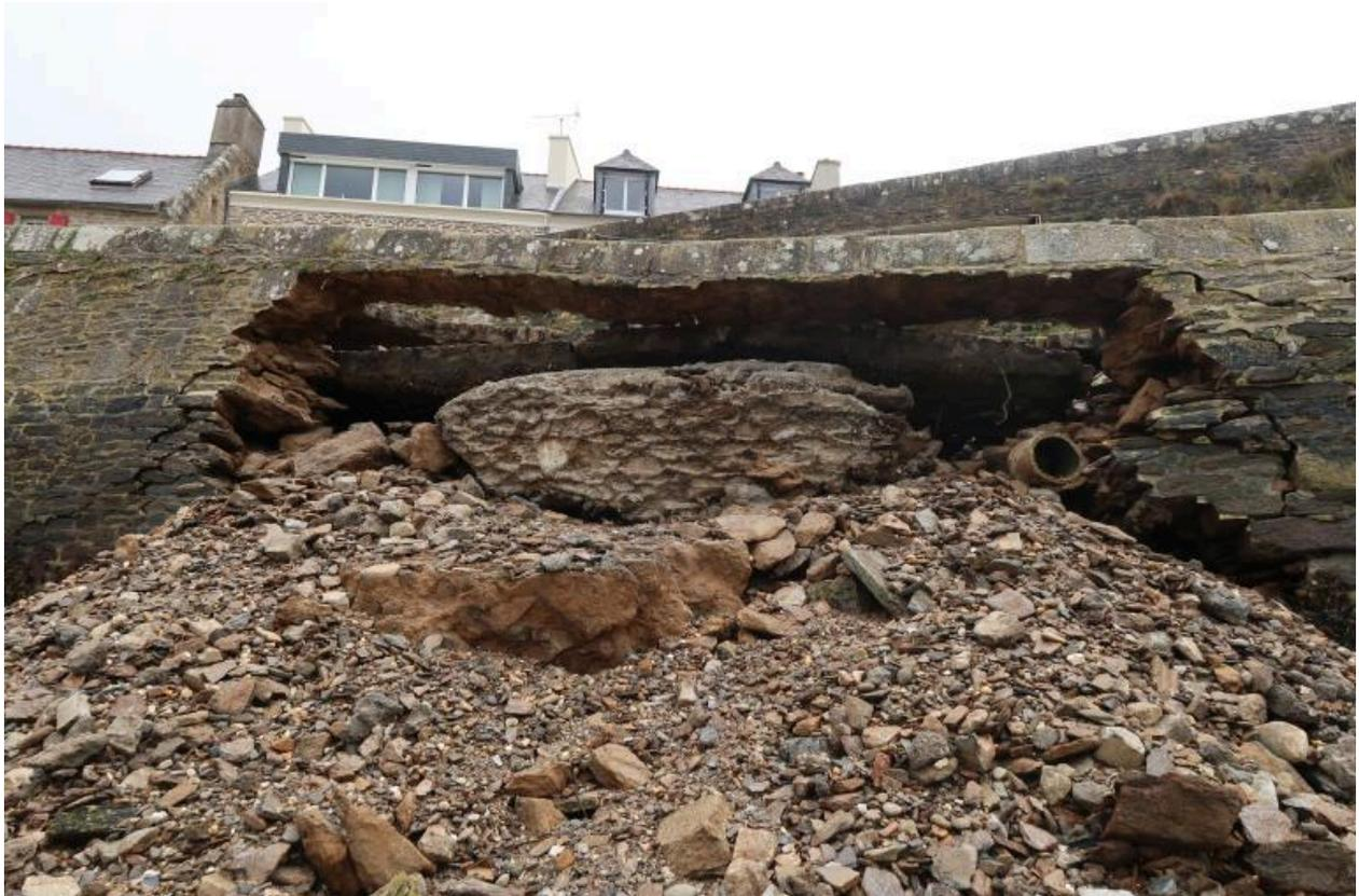
Effondrement de la cale : remblais de terre et de galets et dispositif de collecte des eaux pluviales
