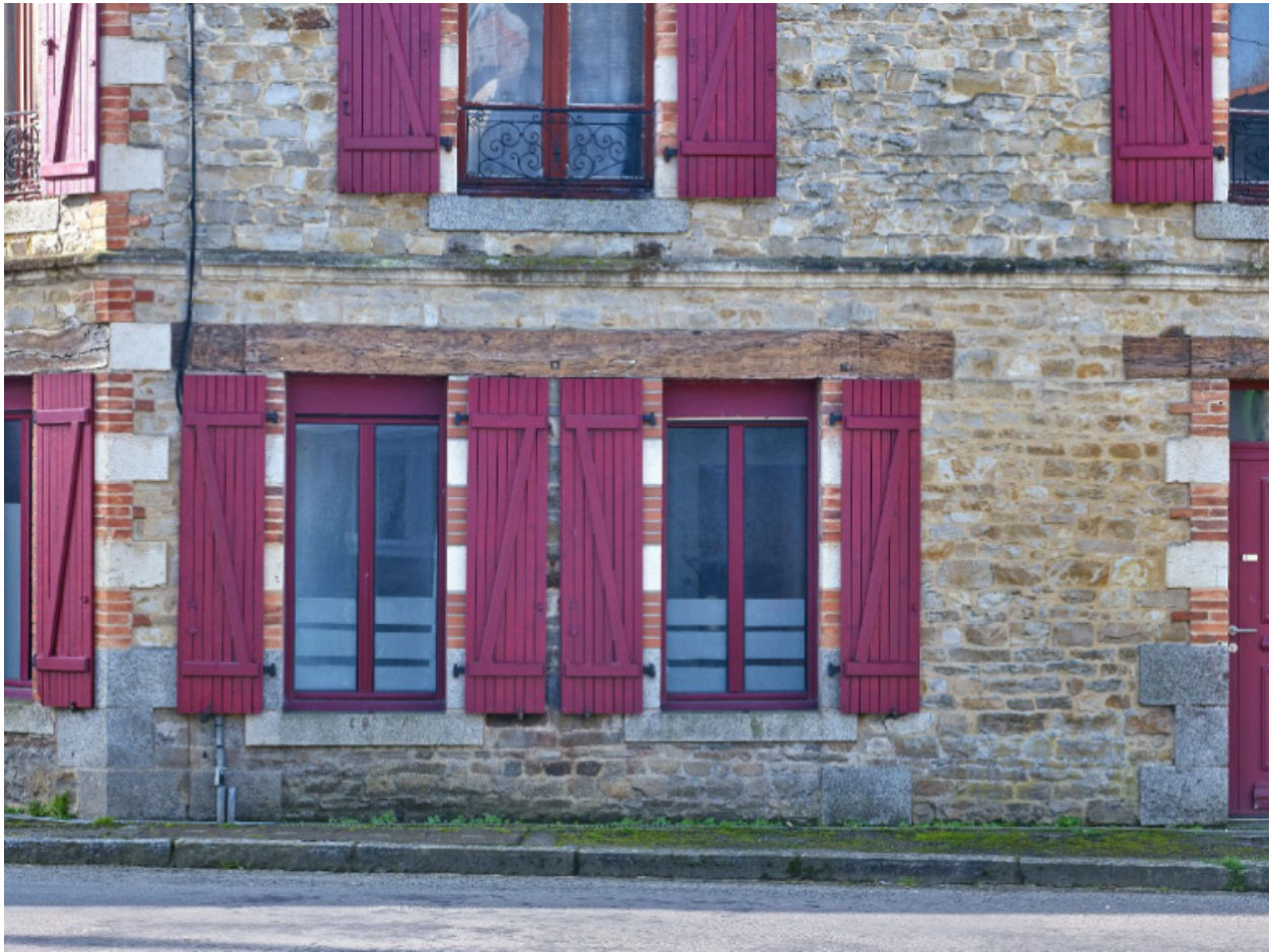
Détail de la façade de l'ancienne épicerie Robert avec linteau bois de grande longueur (ancienne vitrine)
