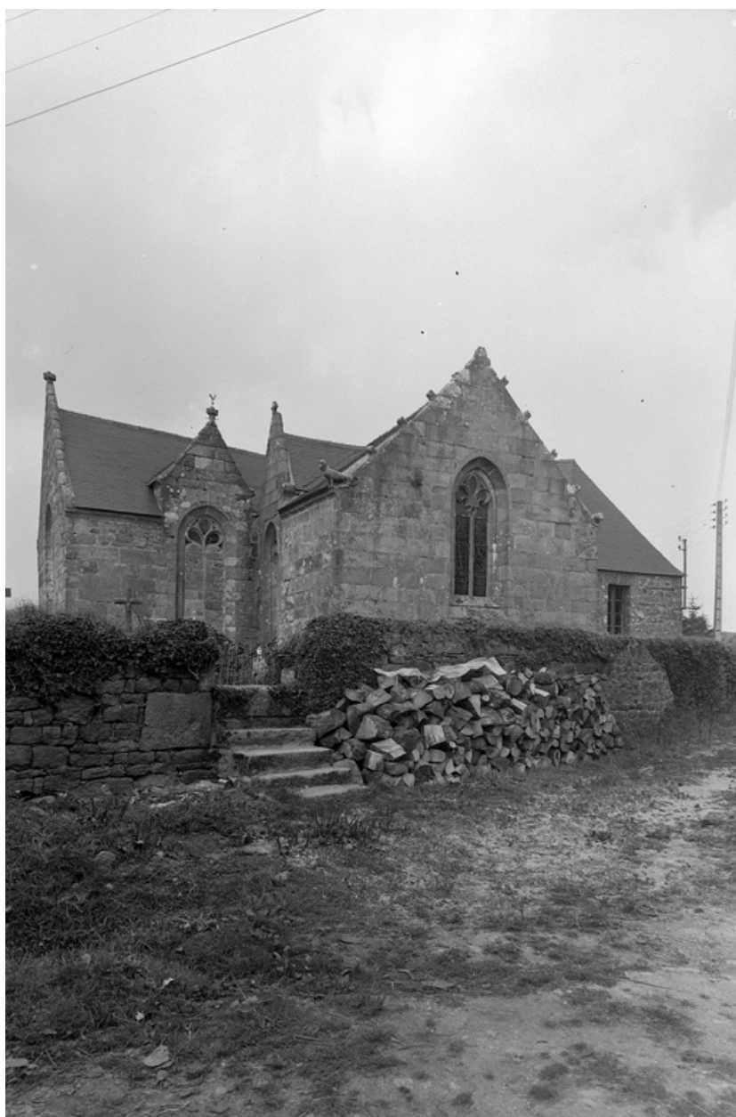
Vue de situation prise de l'est
