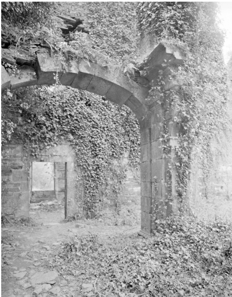
Cloître, détail : arcade au sud est : vue prise de l'est (état en 1977).
