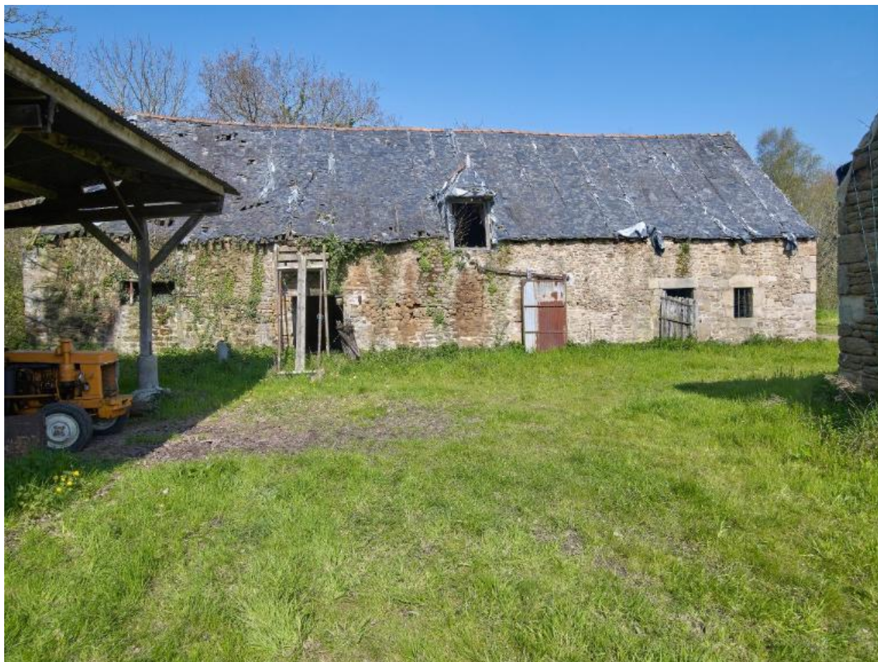
Dépendances, la grange, façade est
