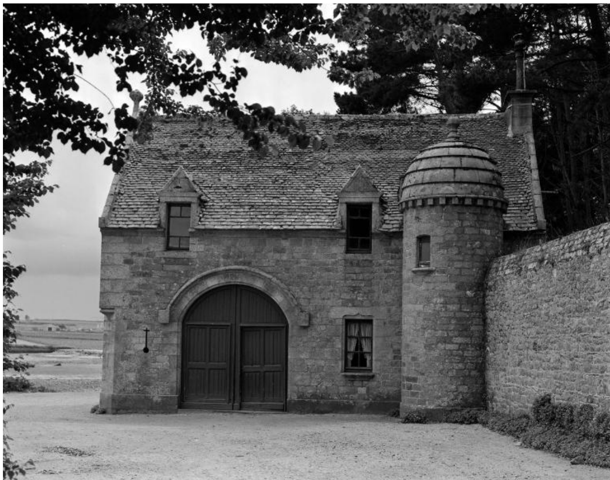
Maison de garde, élévation nord, vue générale
