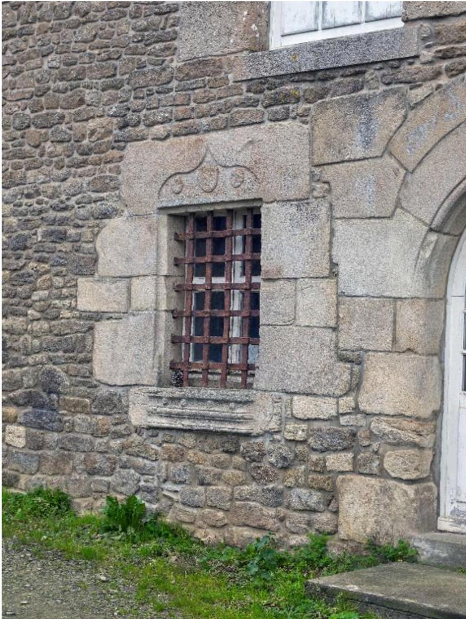
Façade est. Fenêtre de la chambre basse défendue par une grille en fer forgé
