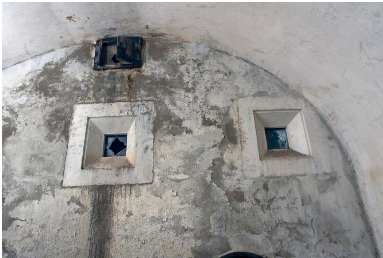
Brest : le fort de Penfeld, cavalier, magasin à poudre, photographie réalisée le 13 mai 2009
