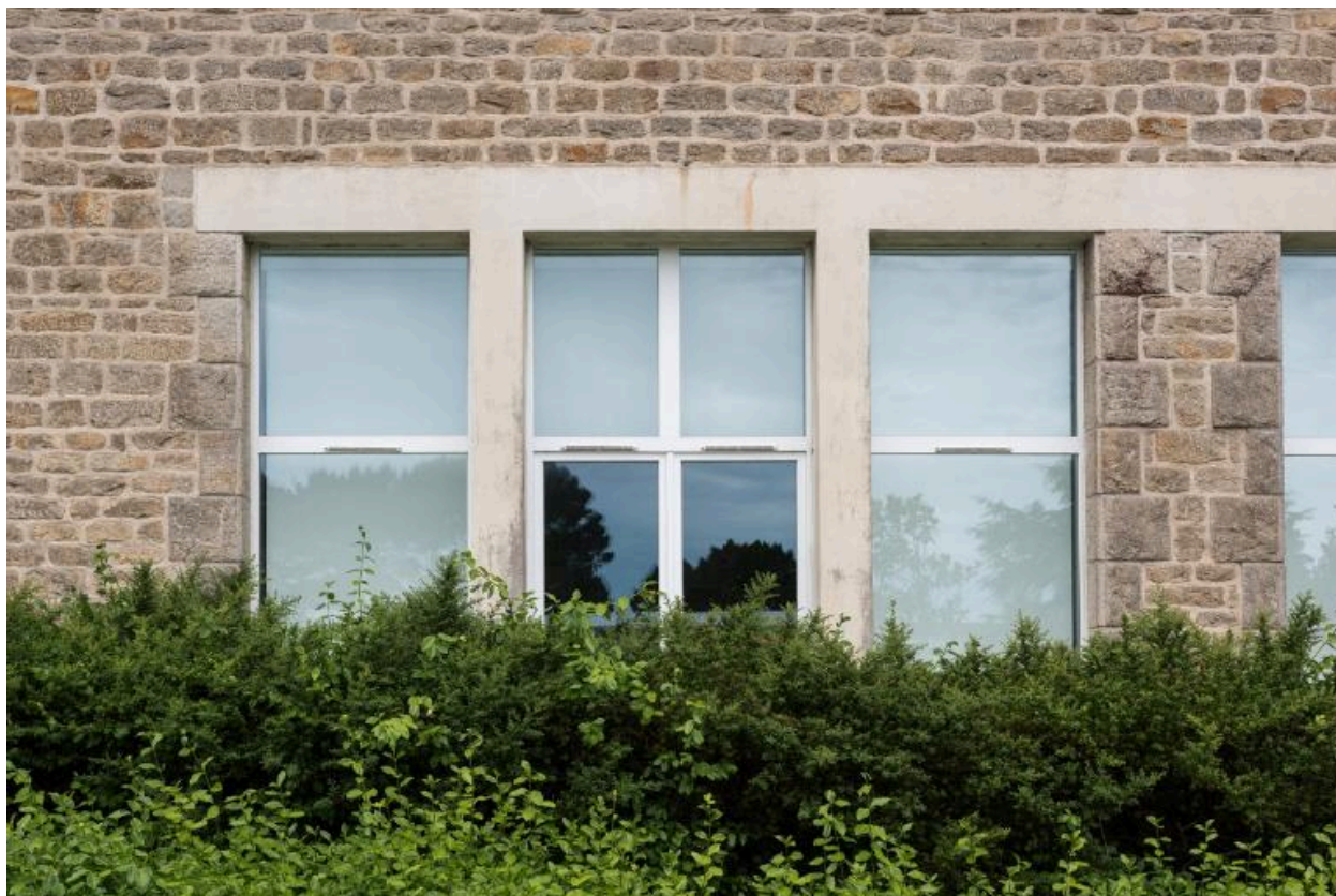
Détail sur des baies de la façade est de l'aile nord. Georges-Robert Lefort, architecte, 1929.
