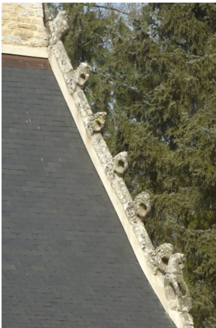
Logis, rampant du pignon, détails
