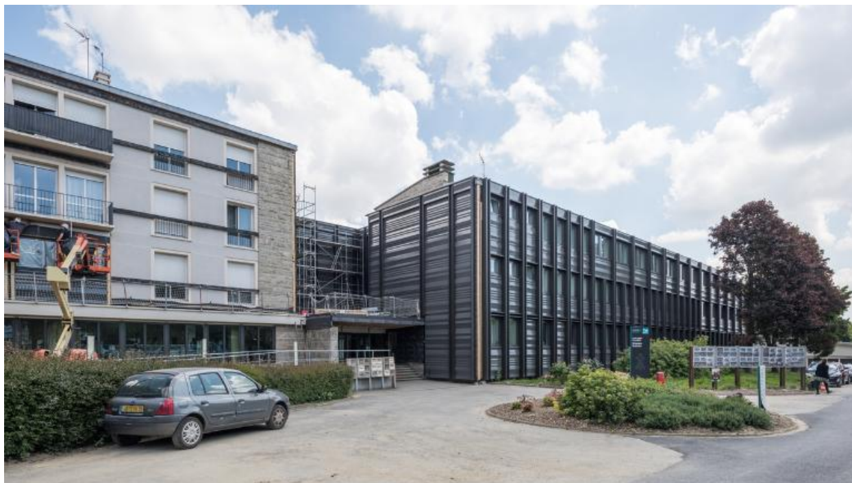
Travaux d'isolation extérieure, bâtiments A et B. Groupe Legendre, architecte : Anthracite 2.0
