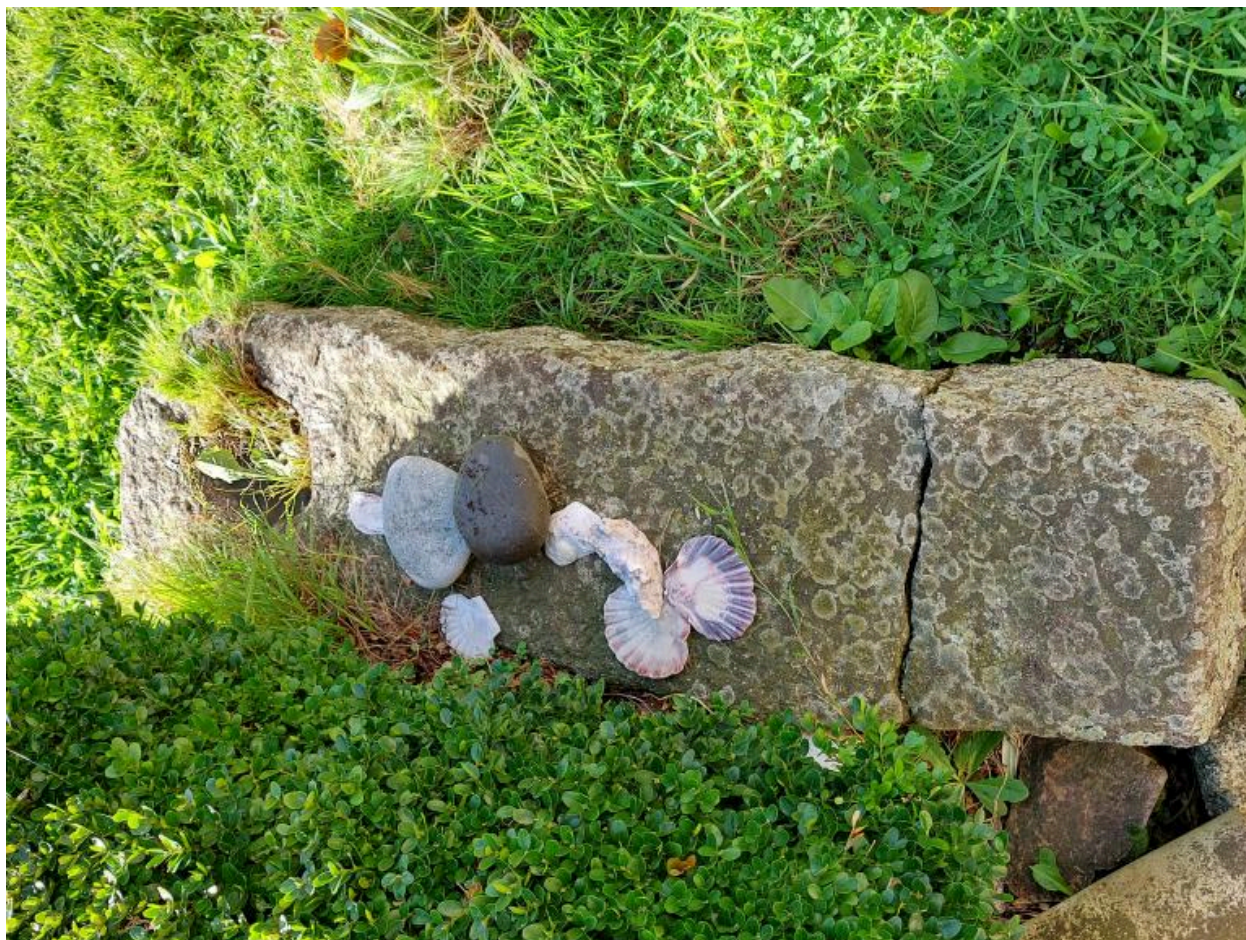
Marche d'un ancien escalier à vis
